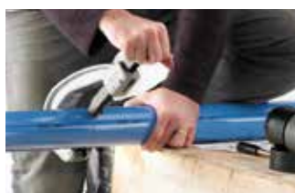
Cortar el tubo
