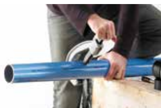
Cortar el tubo
