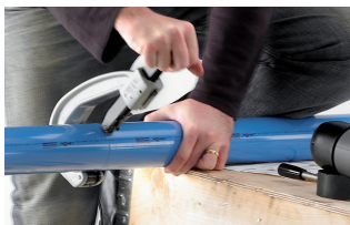
Cortar el tubo
