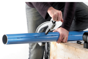
Cortar el tubo
